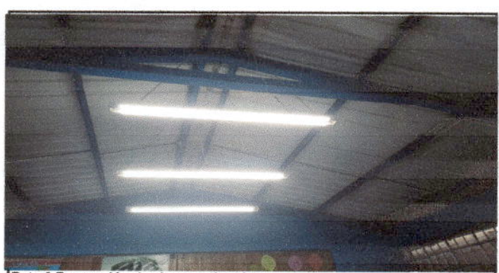
Foto 6 Reparación de sistema electrico
