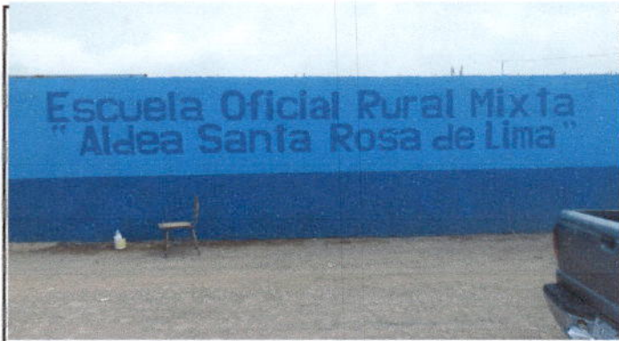
Foto 9 Pintura en muros exteriores e interiores
