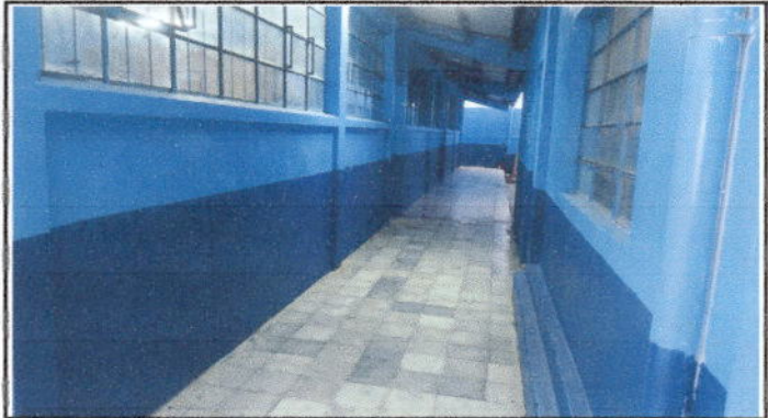
Foto 8 Pintura en muros exteriores e interiores
