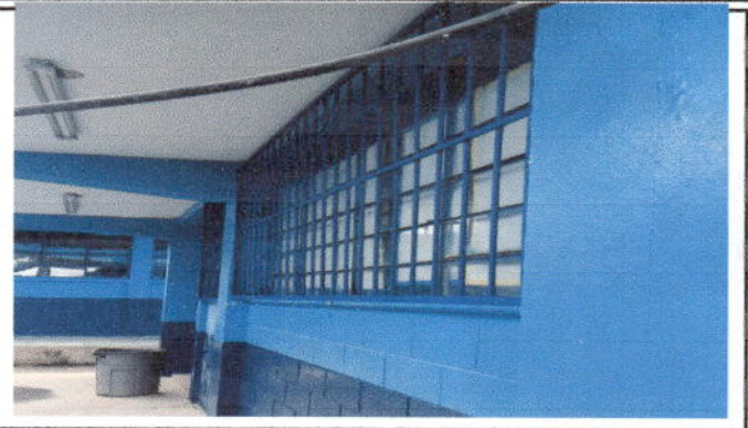
Foto 2 Sustitución de barandas metálicas
