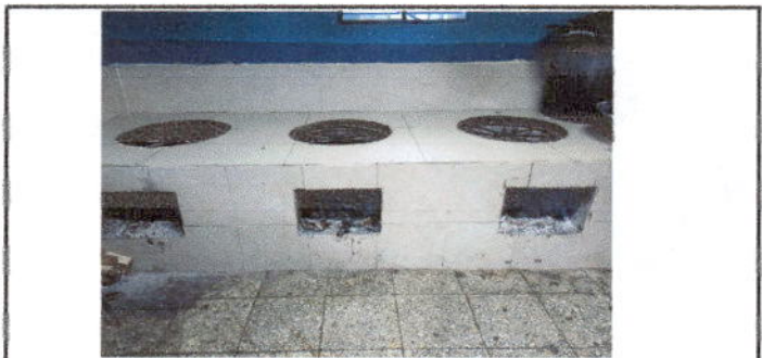
Reparacion de cocina
