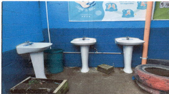
Foto 3 Sustitución de sanitarios y accesorios
