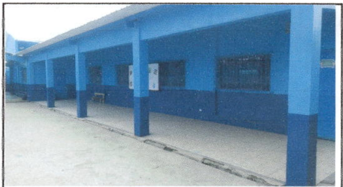
Foto 10 Pintura en muros exteriores e interiores
